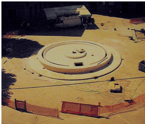
Piazza Garibaldi durante i lavori di sistemazione
